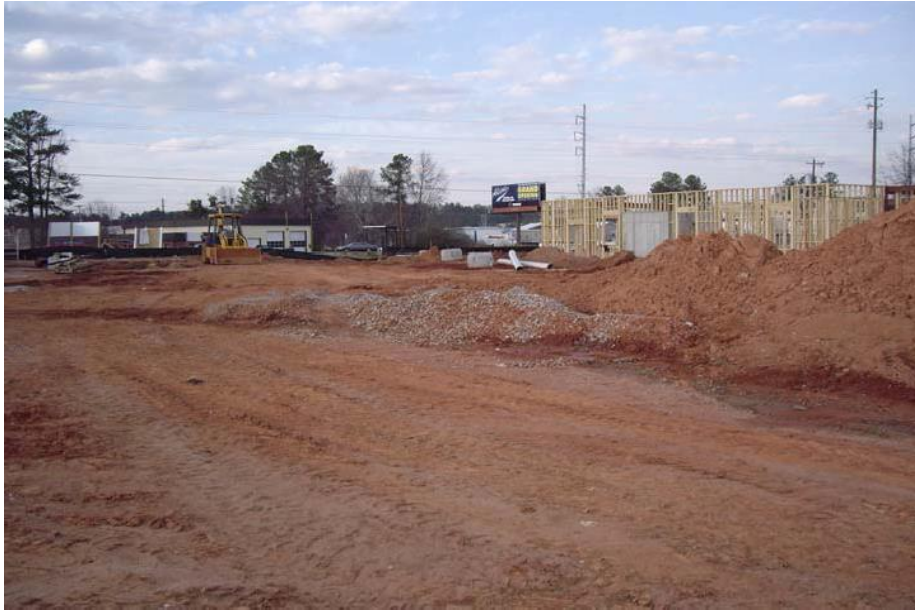
Fig. 3 El movimiento de equipo pesado sobre el terreno durante construcción puede compactar el terreno profundamente. Este tipo de compactación debe ser corregida antes de plantar o los arboles tendrán mayor tendencia a desarrollar raíces superficiales y ser más susceptibles a estrés humedad.
