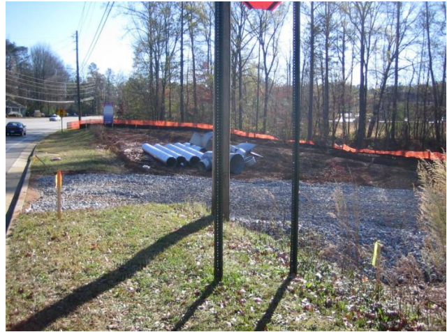
Entrada de piedras al sitio de cosecha de madera—se ayudan prevenir llevar tierra en las calles públicas.
