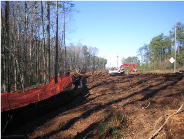
Barreras de protección de los árboles y barreras de limo instalados bien al sitio de cosecha de madera.
